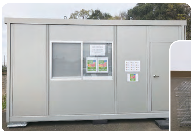
農林業センター内に設置された鳥獣害対策の拠点となるユニットハウス
