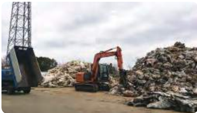
大量の廃ビニール・ポリ等を回収しました
