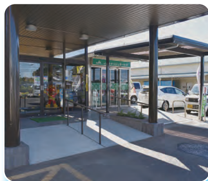
全面スロープ化された出入口
